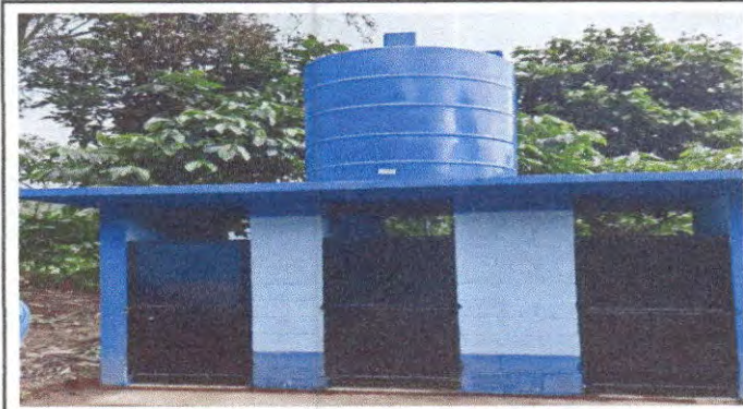
Foto 4: Sustitución de depósito de agua 1100 lt
