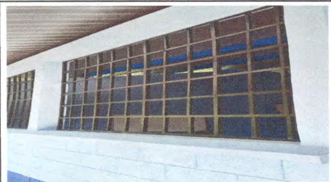
Foto 3: Mantenimiento de estructura de metal ventanas.
