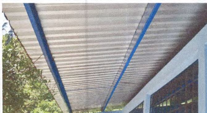
Foto 8: Mantenimiento a soporte de estructura de metal.
