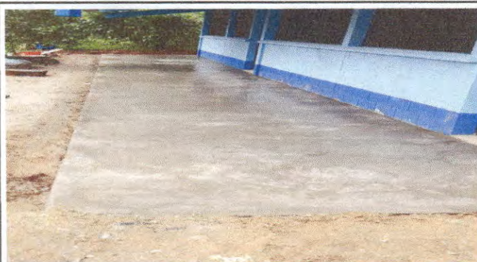
Foto 9: Reparación de piso de torta de concreto
