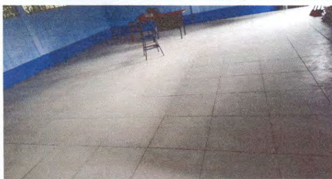
Foto 7: Sustitución de piso torta por ceramico.
