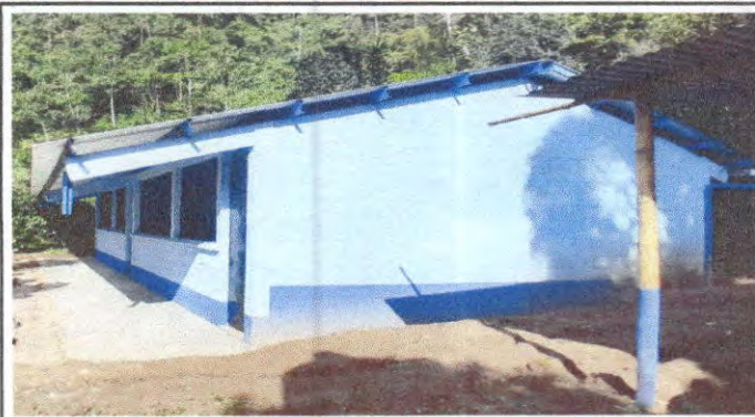
Foto 2: Pintura en muros exteriores e interiores
